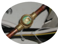
Schauglas und Filtertrockner
