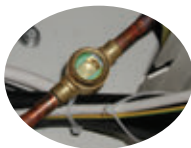
Schauglas und Filtertrockner
