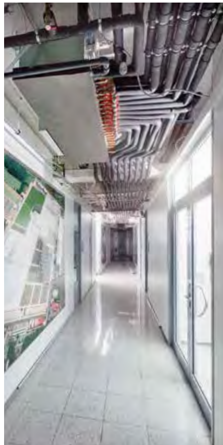
Immer leicht zugänglich: Die Hybrid BC-Controller sind in der Zwischendecke des Flures untergebracht.
