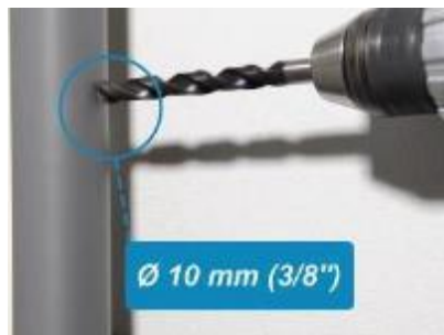
1. Bohrloch für Ablaufstutzen erstellen
