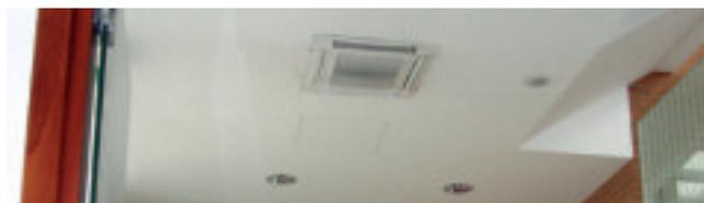
Für Einbauten in der Zwischendecke, z. B. die klassische Hotelzimmersituation zwei Modelle Truhengerät DXC oder DXD
