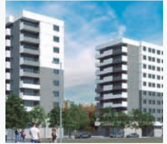
Flumen Plus. Wohngebäude im Passivhausstandard. Zaragoza, Spanien. PACi
