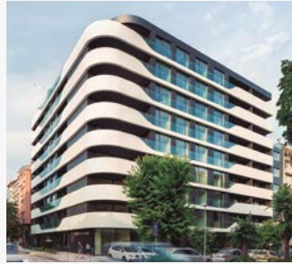
Gebäudekomplex Varna Wave. Wohngebäude. Varna, Bulgarien. Aquarea und Aquarea Smart Cloud
