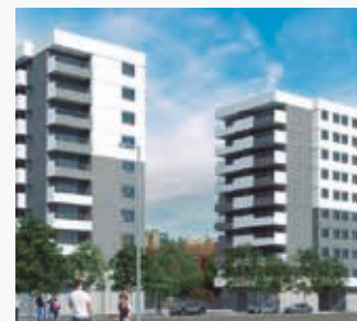
Flumen Plus. Wohngebäude im Passivhausstandard. Zaragoza, Spanien. PACi
