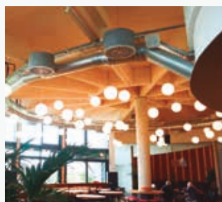
Metzgerei Weinbuch. Einzelhandelsgeschäft – Restaurant. Öpfingen, Deutschland. VRF, Raumklimageräte und Kältetechnik
