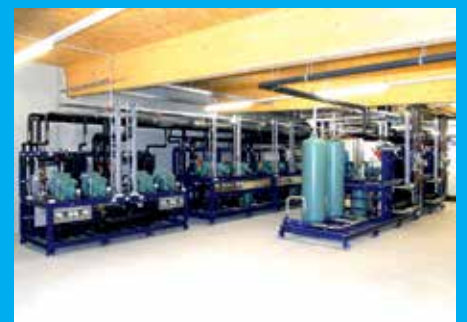
Verbundanlagen für Verteillager
