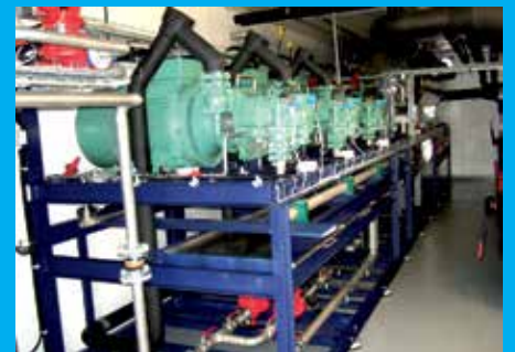
R717 Kältsole Erzeuger in Groß-Bäckerei
