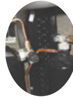
Saug- und Druckseite mit Rotalockventil
