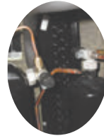
Saug- und Druckseite mit Rotalockventil
