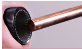
2. Rohr innen und außen entgraten
