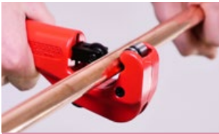
1. Kupferrohr ablängen
