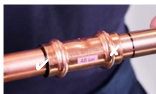
10. Rohr in den Fitting einführen
