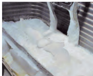
Eisbildung am Außengerät ohne Wannenheizung
