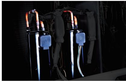
Ausschließlicher Einsatz von invertergesteuerten Hochleistungsverdichtern.
